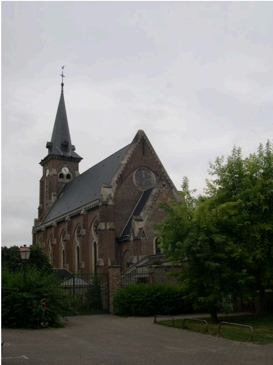
Vue depuis le sud-est.
