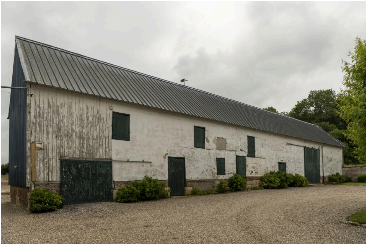
Grange, fenil et étable, en fond de cour, vue depuis le nord.
