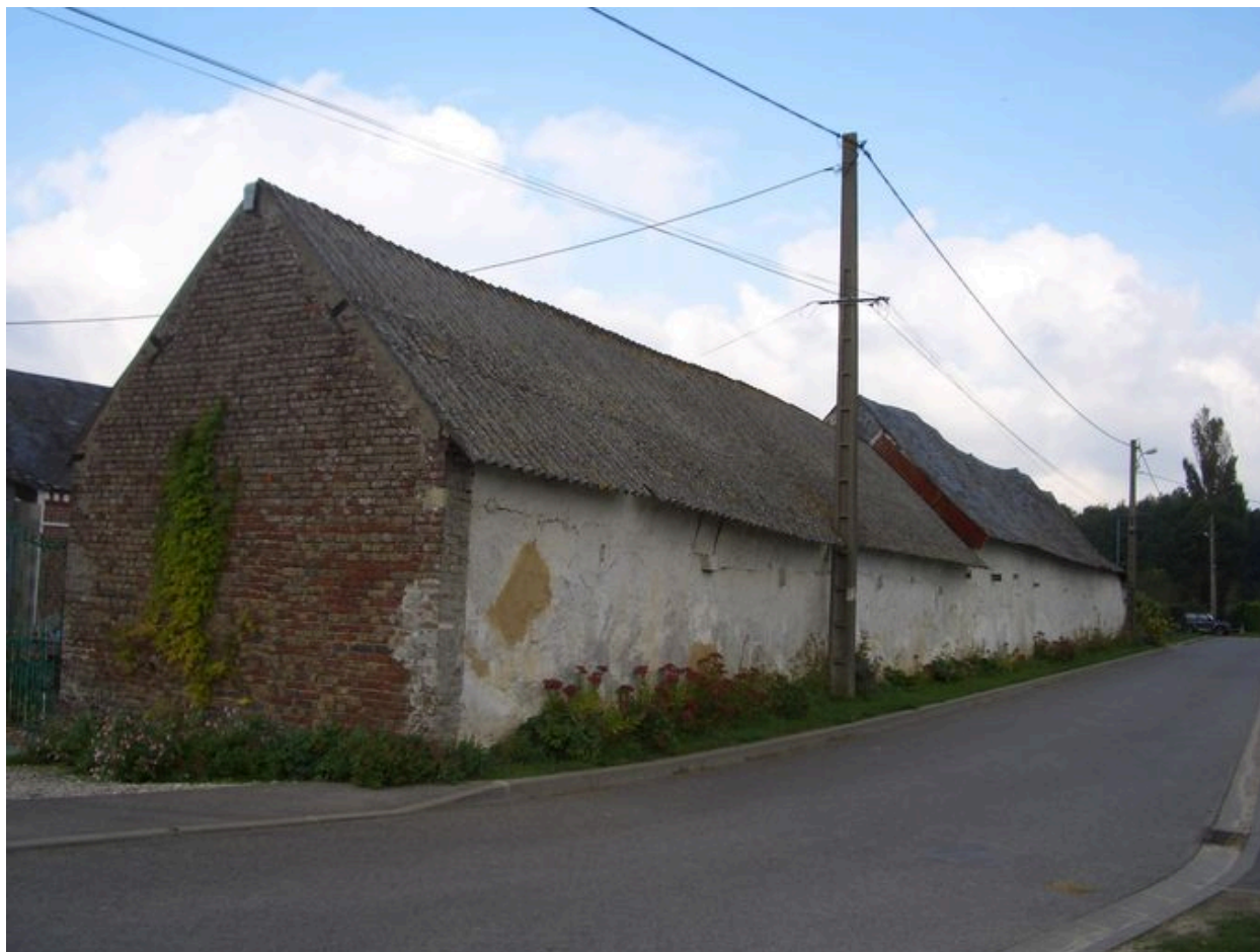
Vue des bâtiments sur rue depuis l'ouest.
