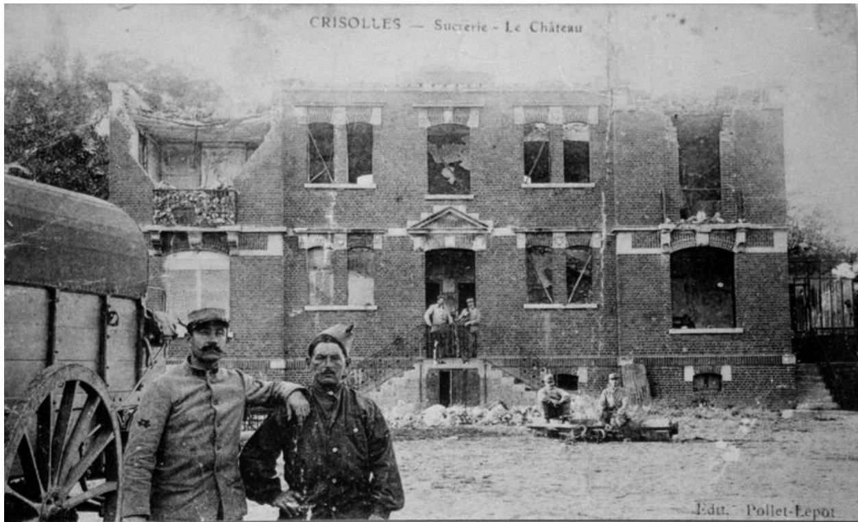
Façade sur cour, après les bombardements de 1918 (AP).
