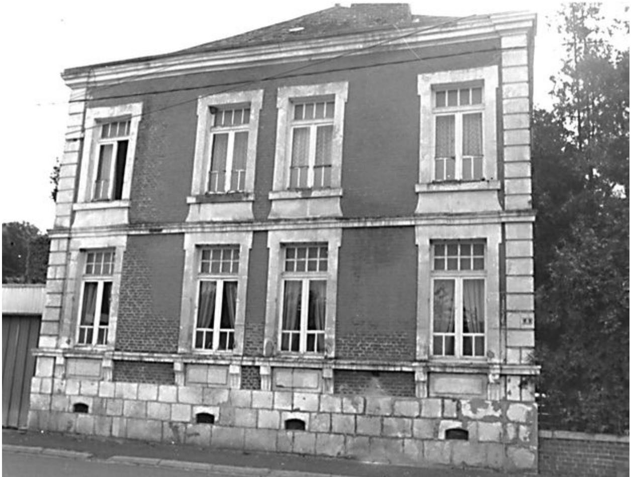
Elévation nord, sur rue.
