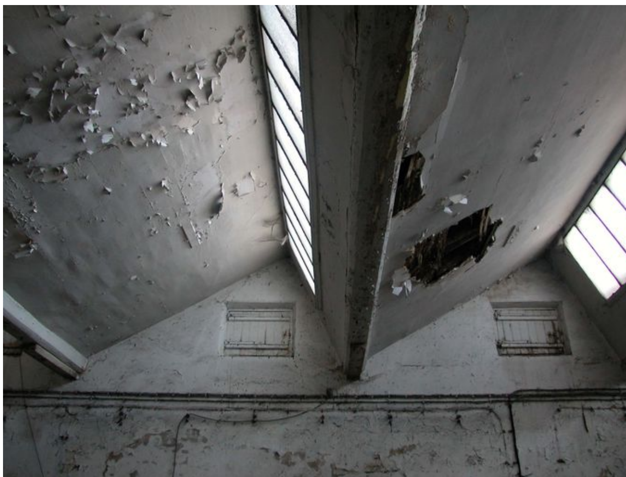
Vue intérieure des sheds des ateliers.
