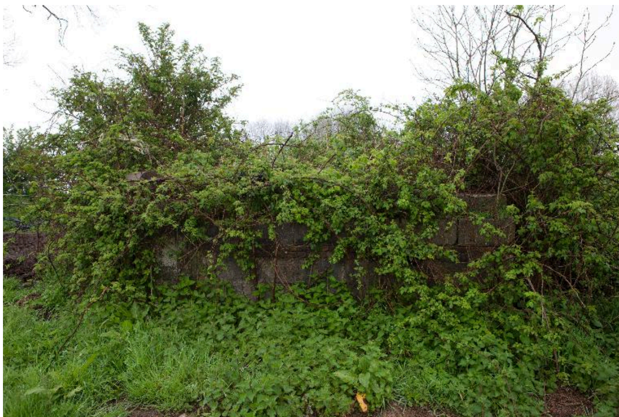
Bunker de tir.
