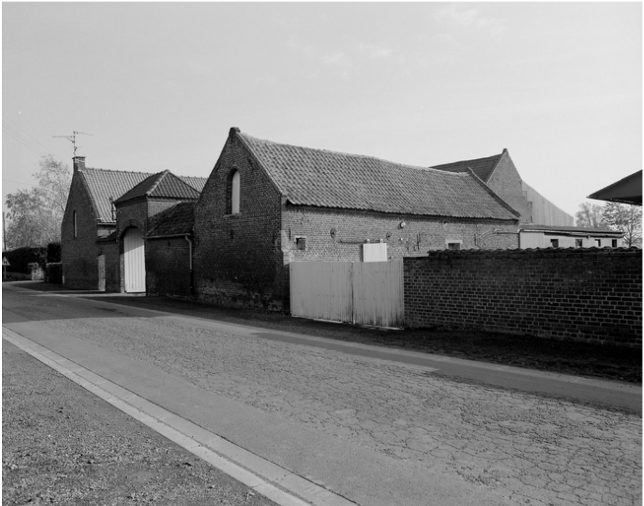
Ferme, 344, rue de Balory, vue générale.
