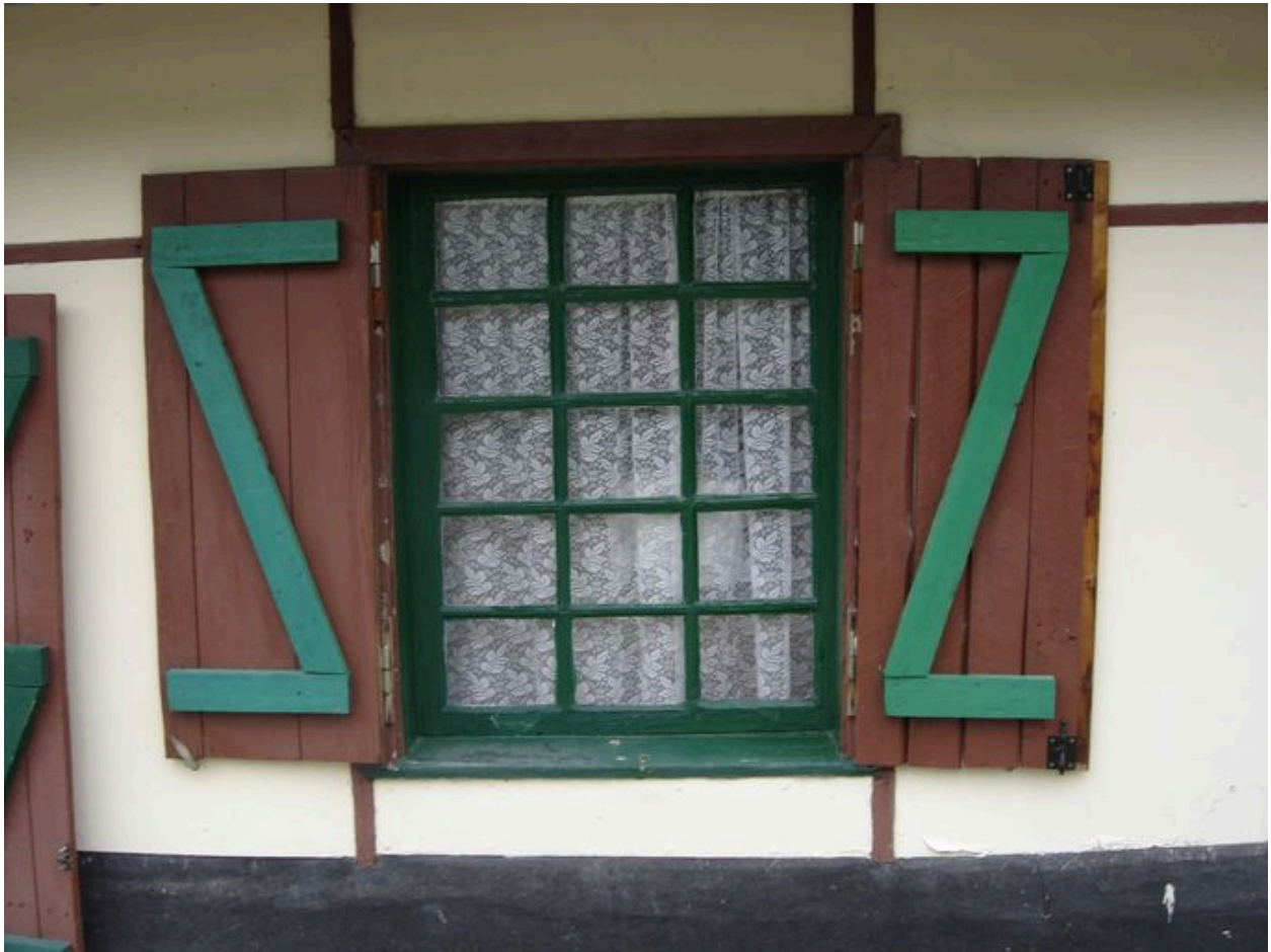
Vue d'une baie à quinze carreaux.
