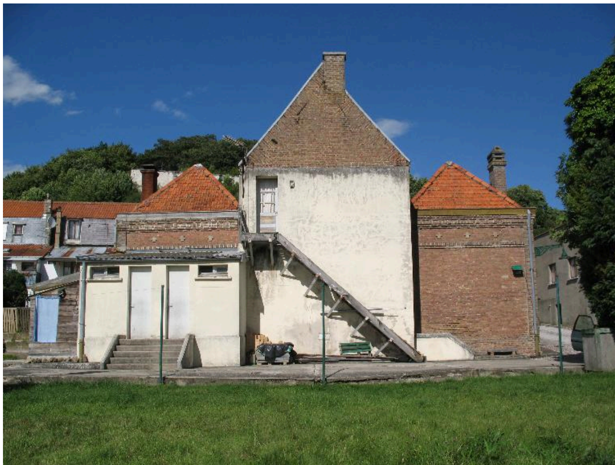
Vue d'ensemble de la façade postérieure.
