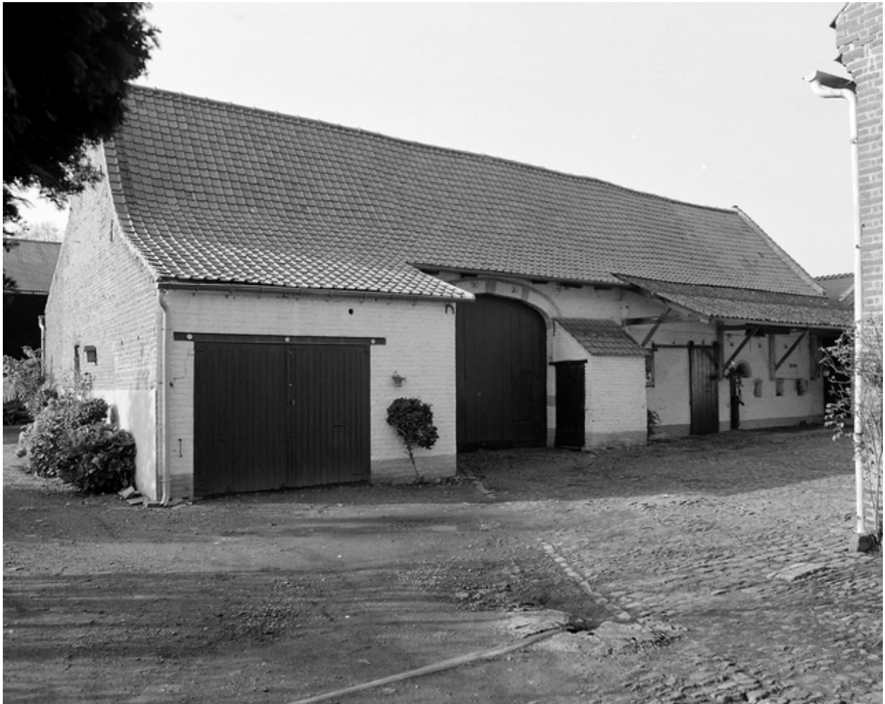
Ferme, 160, rue du Presbytère, la grange.
