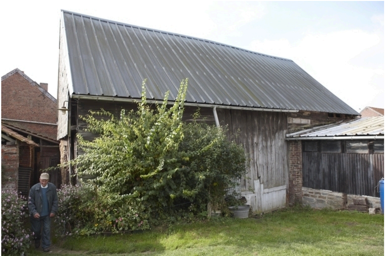
Vue du revers de la grange.
