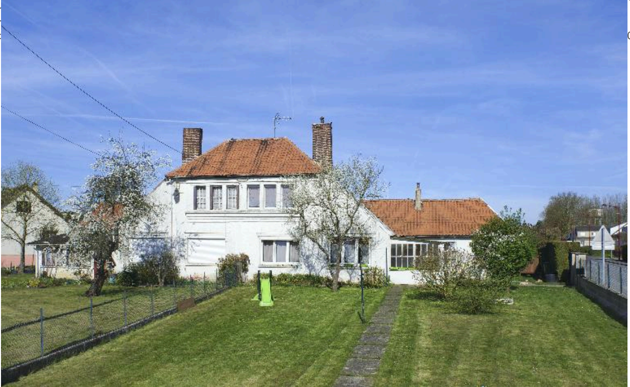
Maison à deux unités d'habitation de type "living room" (21, rue de la Victoire et 2 allée des Marguerites). Façade postérieure.
