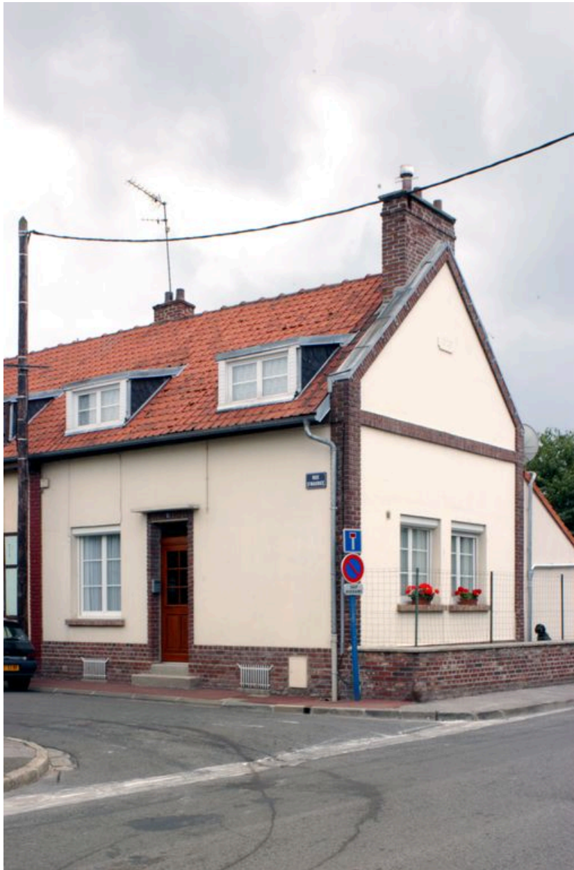
2 rue Saint-Maurice. Vue partielle d'une maison construite en 1858.
