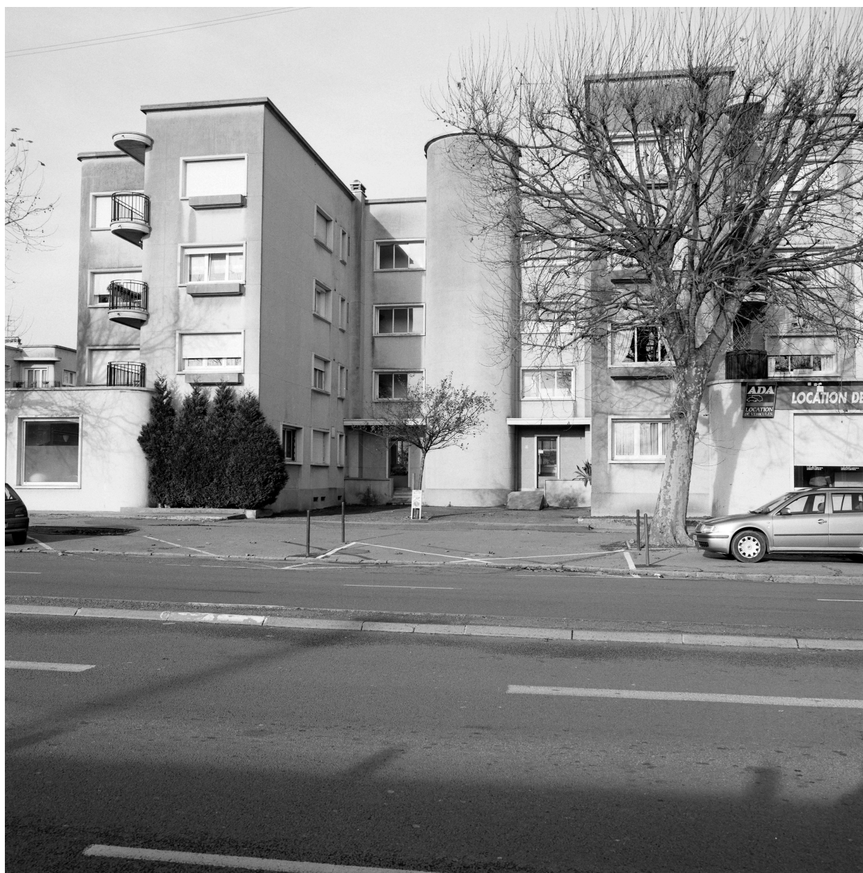
Vue générale de l'élévation sud d'un immeuble en H, avenue de la gare.
