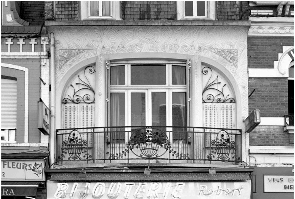
Détail de la baie triple du premier étage, avec son balconnet de fer forgé.
