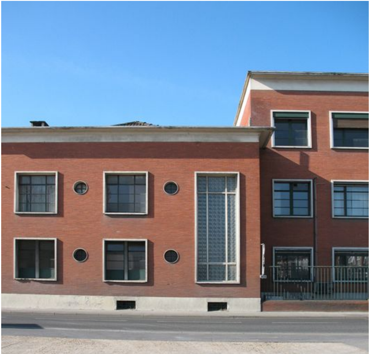
Détail de la façade des bureaux.
