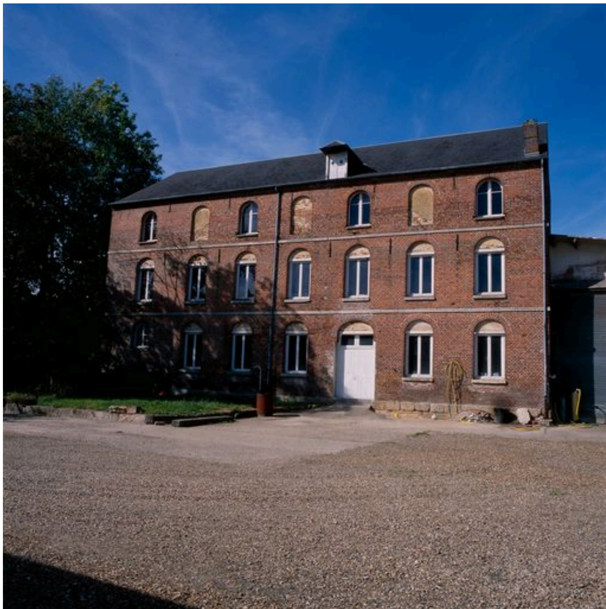
Vue d'ensemble sur cour.
