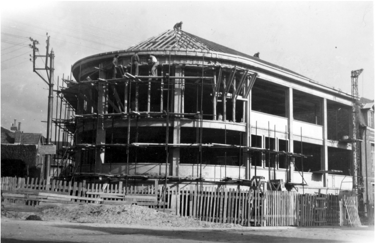
Chantier de construction des ateliers, 1948 (IFA).
