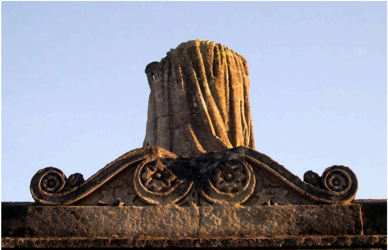
Vue de détail du couronnement, face nord.
