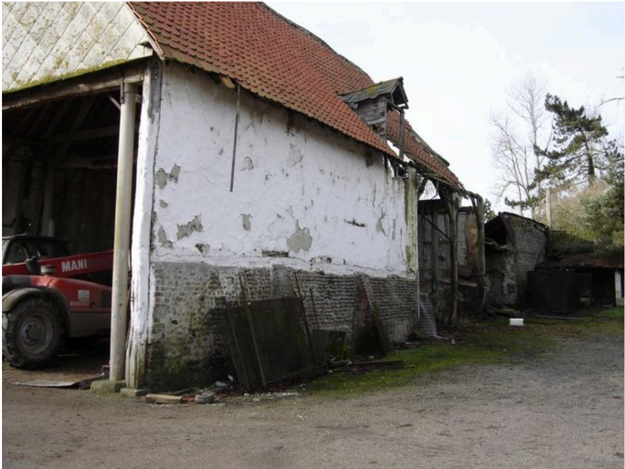
Vue du côté nord de la grange.
