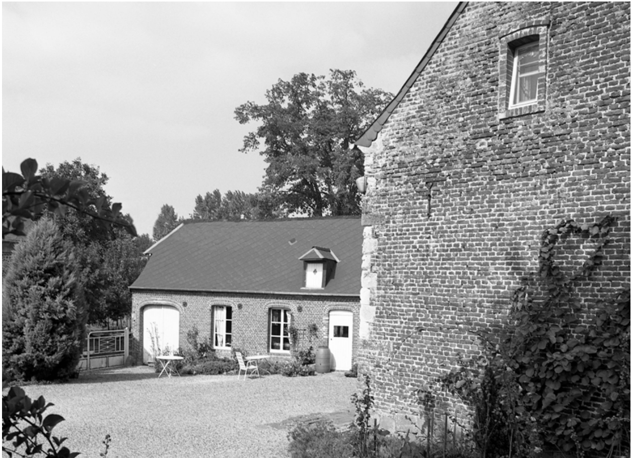
Anciennes étables : élévation sur cour.
