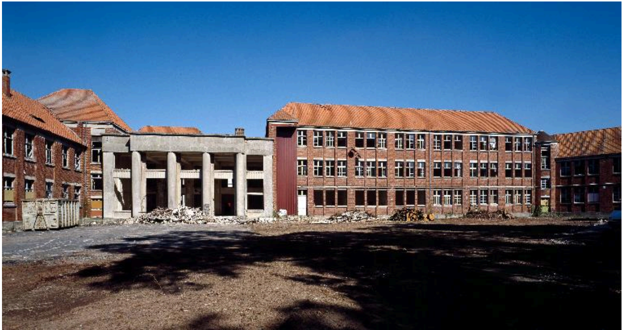
Vue de la façade sur cour, en direction de la rue Belzaize.
