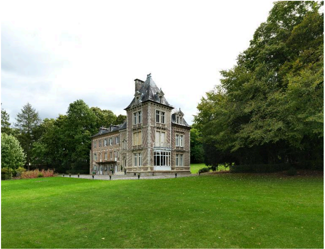
Vue d'ensemble nord-ouest du château.
