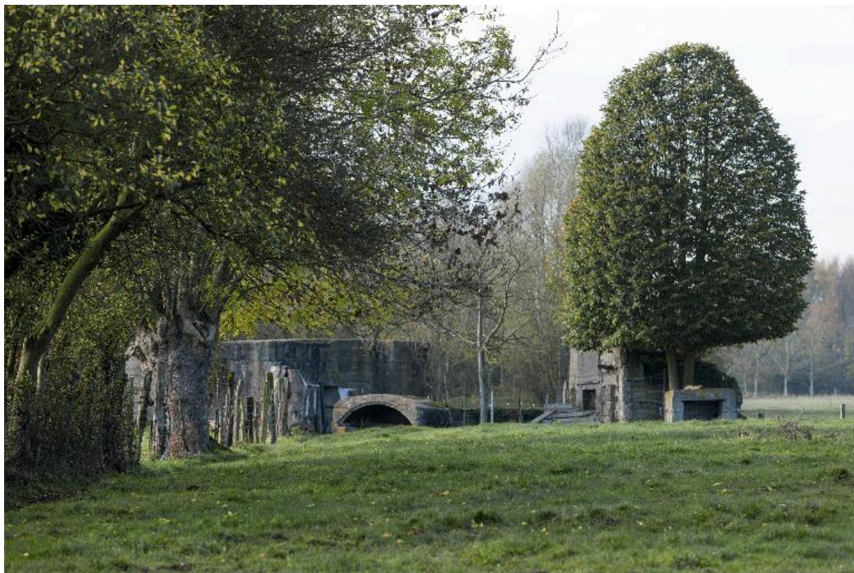
Illies, ensemble fortifié au lieu-dit Lannoy.
