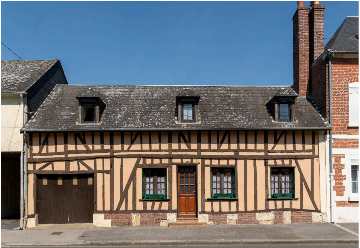
Logis sur rue avec pan de bois apparent, n°14 rue de Beauvais, vue prise depuis l'est.
