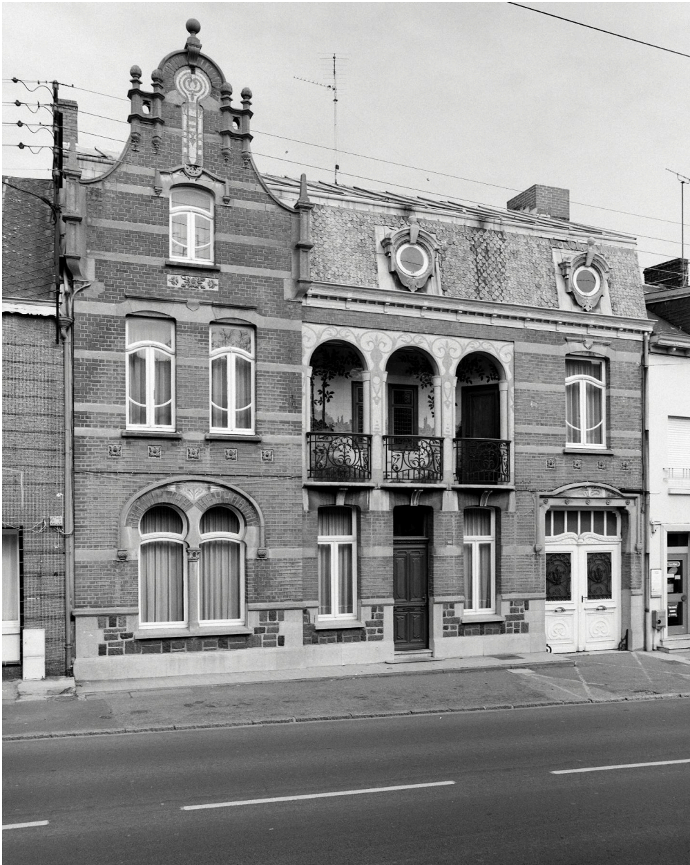
Vue générale de l'élévation antérieure.
