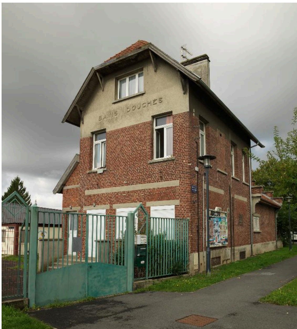
Bâtiment des bains-douches.
