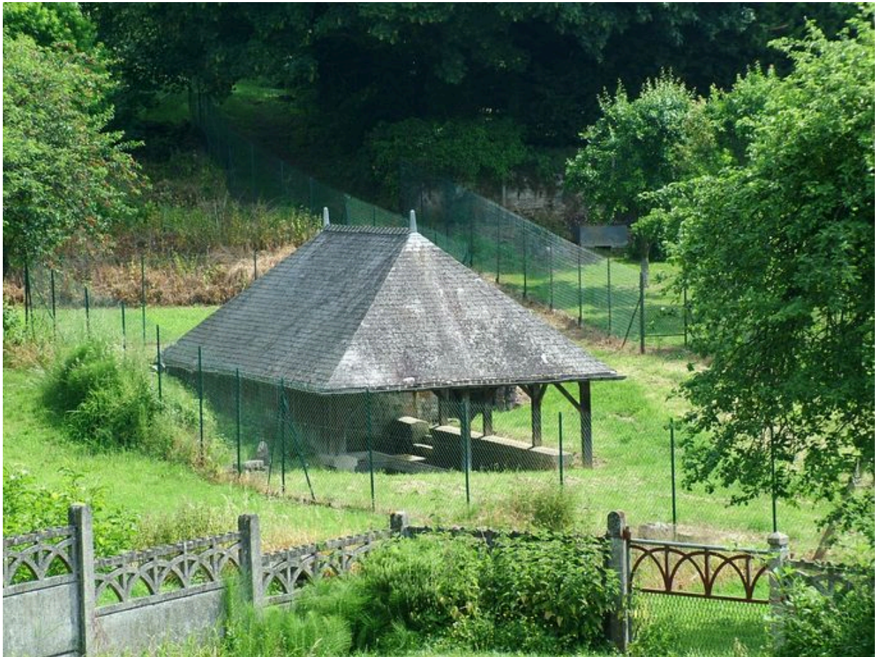
Vue du lavoir.
