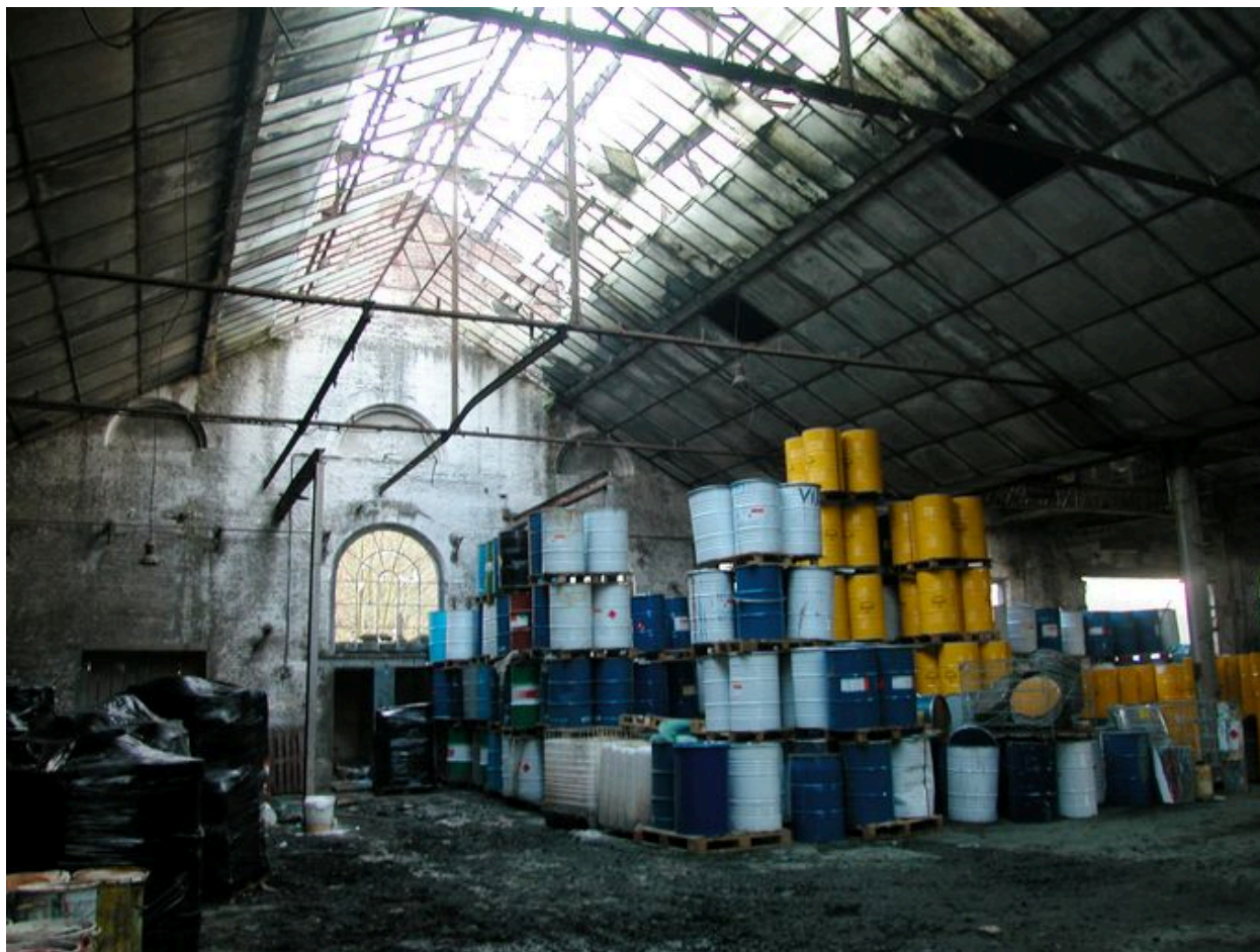
Vue intérieure de l'atelier de teinture.
