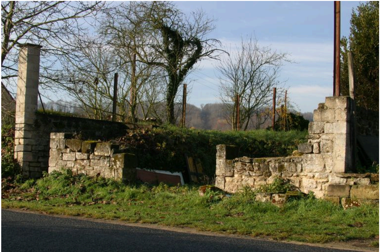
Vue de fondations d'une maison non reconstruite.
