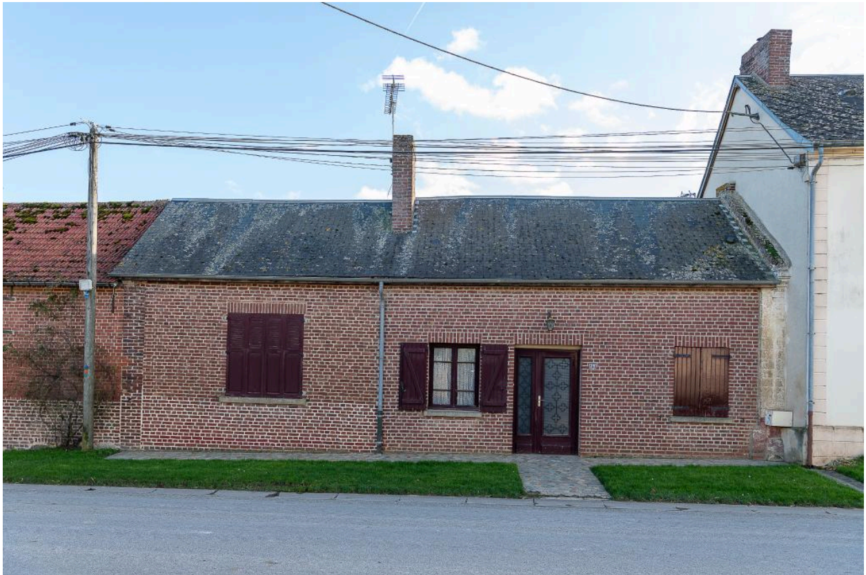
Ancien commerce, n°29 Grande Rue, vue depuis le nord.
