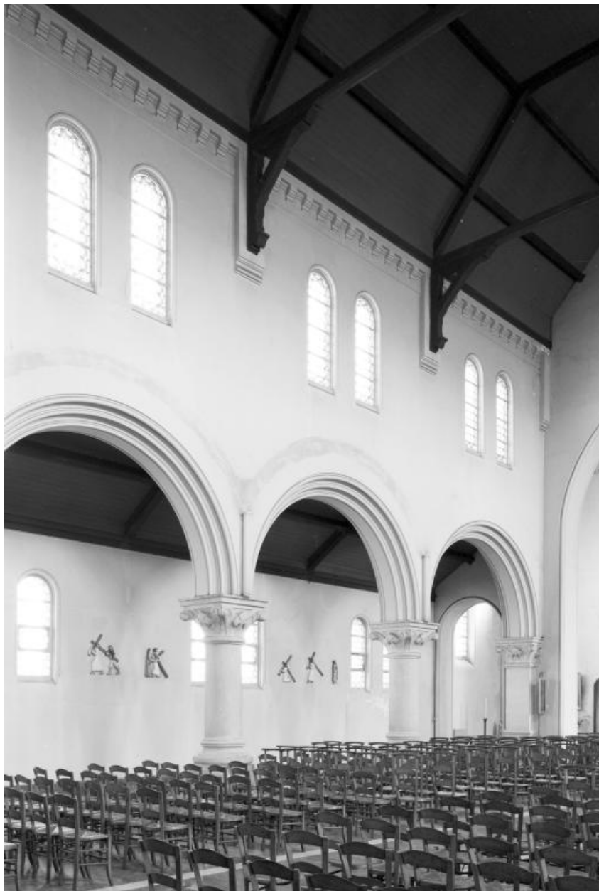
Vue intérieure. Bas côté nord, vers le nord-est.
