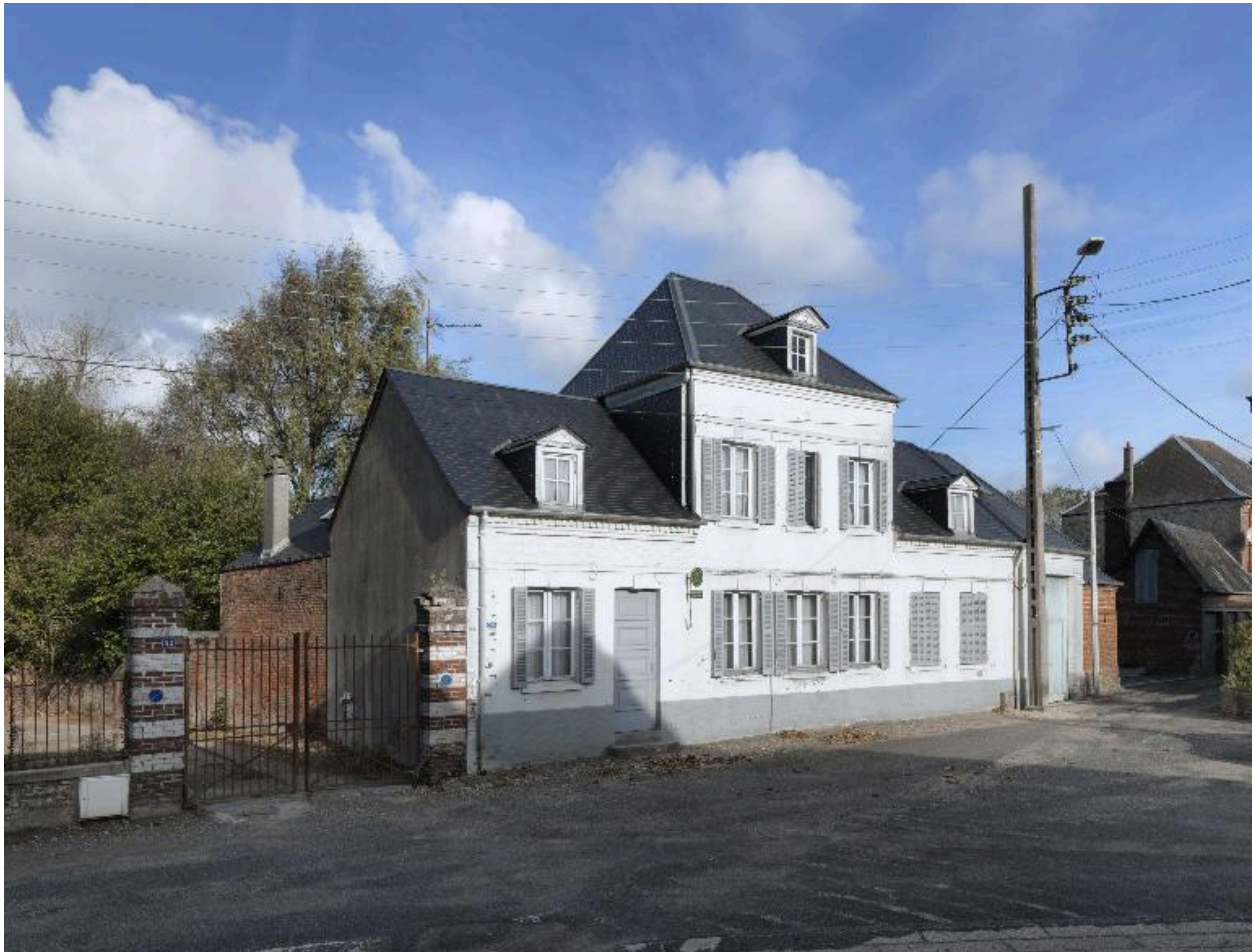
Ancienne épicerie, puis débit de boissons, 30 Grande-Rue.
