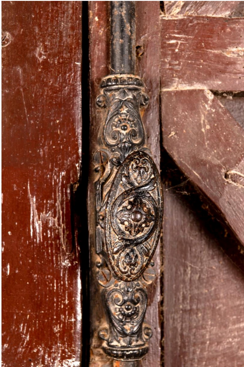
Porte d'entrée, détail des ferronneries, 19e siècle.
