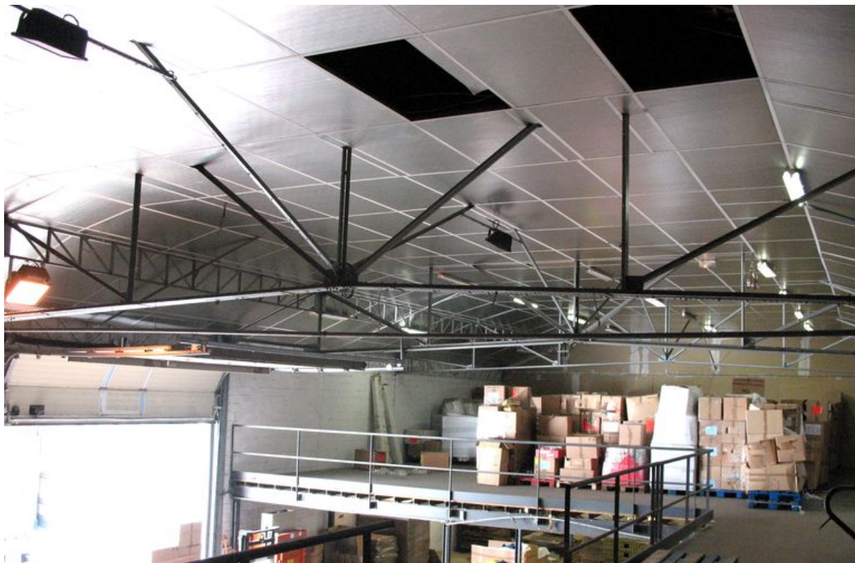
Charpente métallique de l'entrepôt.
