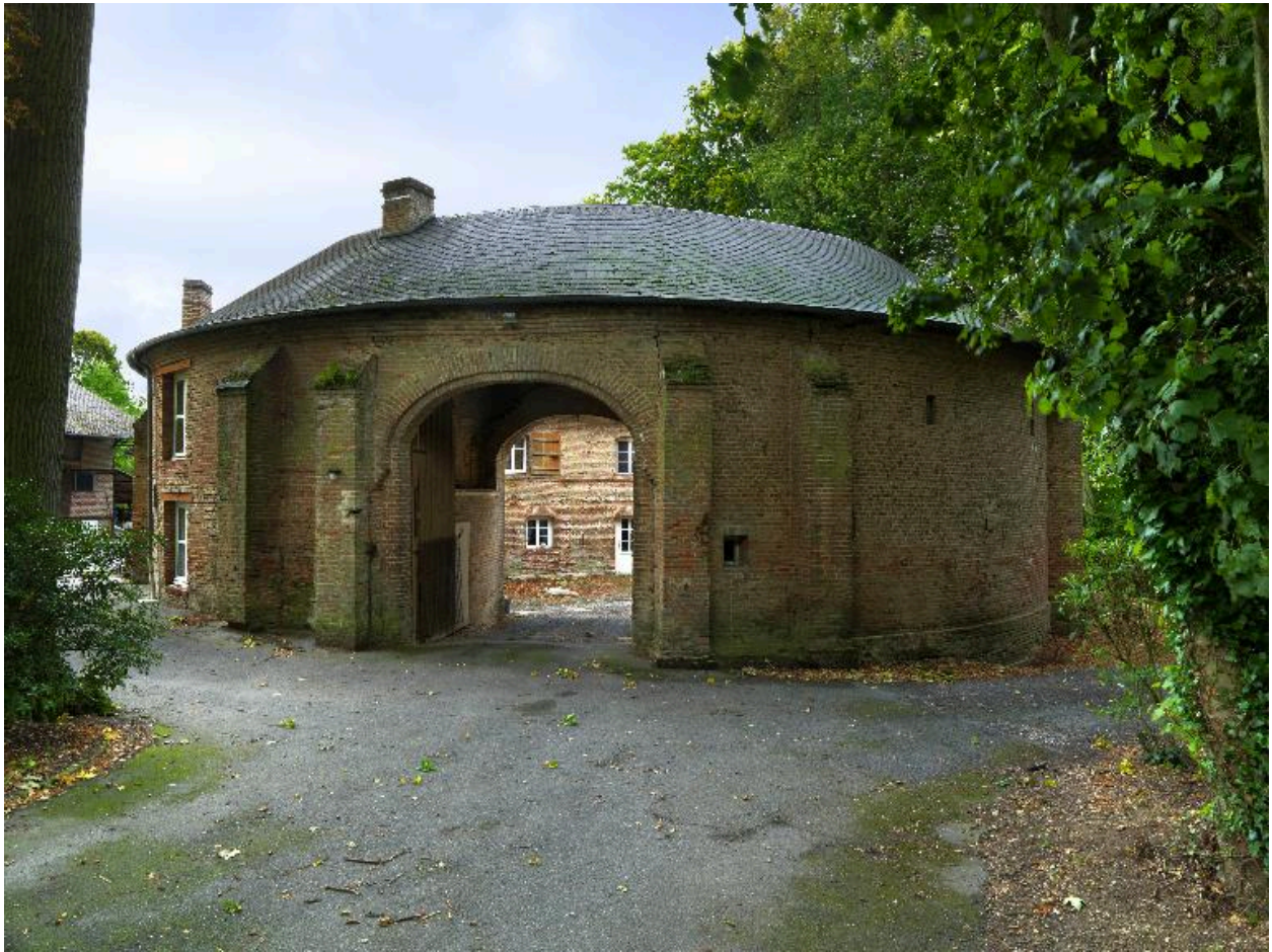
Le porche d'entrée des communs, vue d'ensemble nord.
