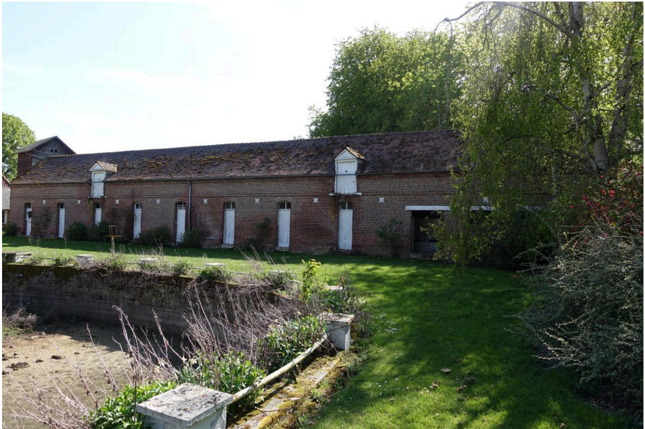
Anciennes porcheries, vue depuis le nord-est.
