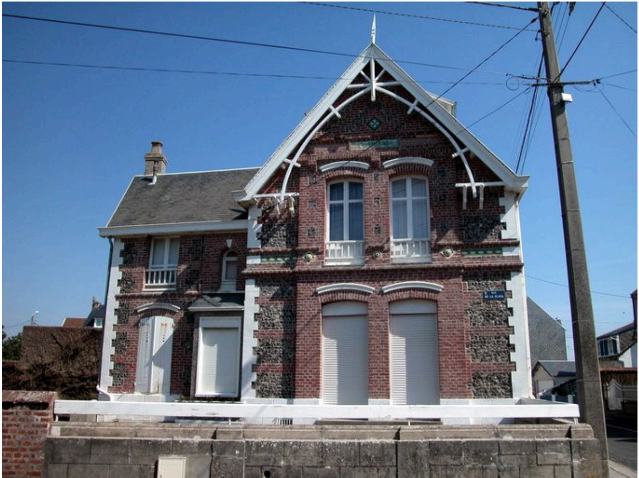
Vue d'ensemble depuis la rue de la Plata.
