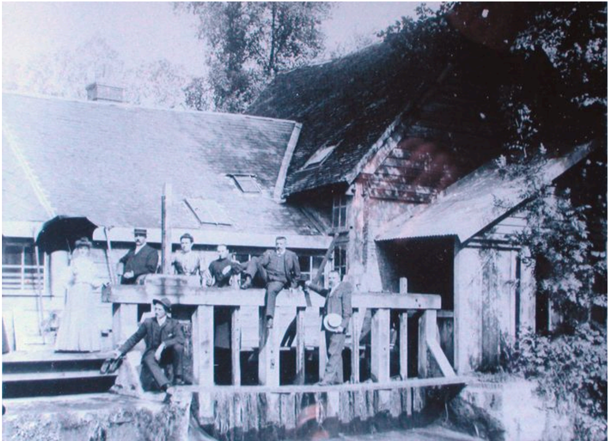
Les vannes et le déversoir de la scierie, vers 1910. (collection particulière).
