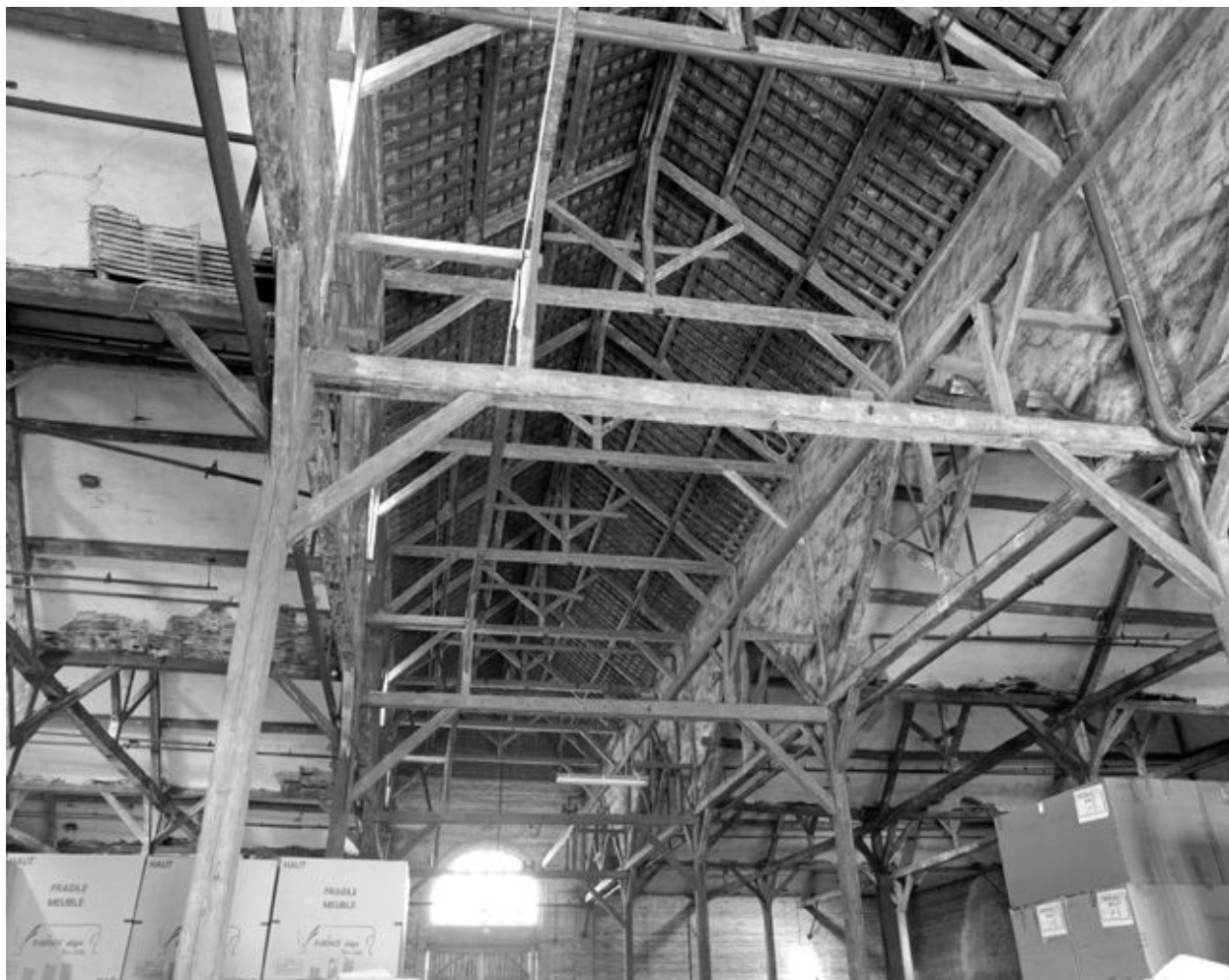
Magasin industriel, en 1989 : vue intérieure (charpente).
