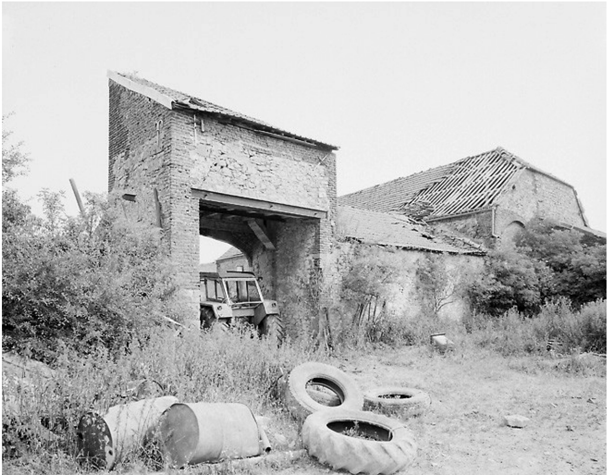
Vue de l'élévation postérieure du pigeonnier-porche de la ferme située 11 rue d'Avesnes.
