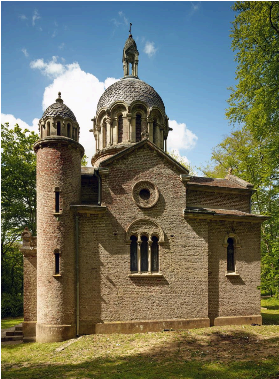
Vue générale de la chapelle Notre-Dame de La Salette depuis le sud.
