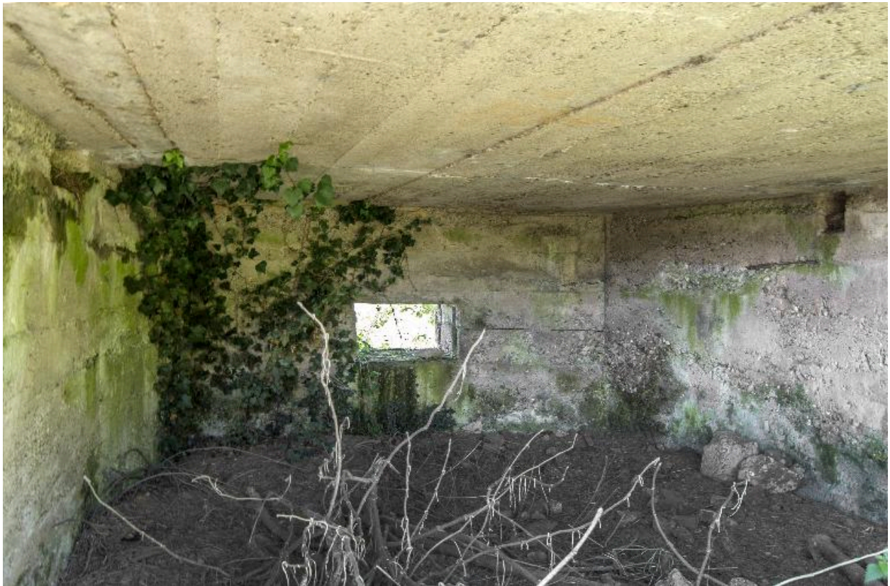
Vue intérieure de la chambre de tir
