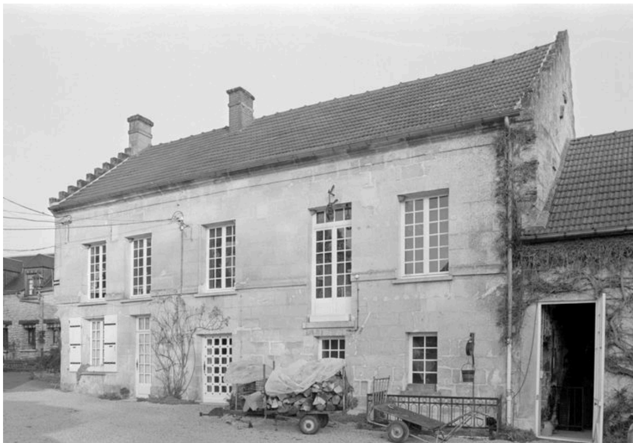
CHELLES. Moulin à farine. Élévation antérieure
