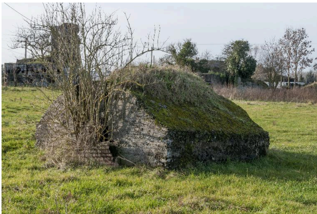
Casemate j, vers le nord-ouest
