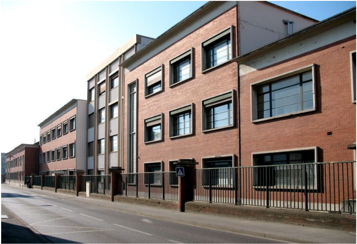
Façade des bureaux construits à partir de 1948 le long de la rue Lénine.
