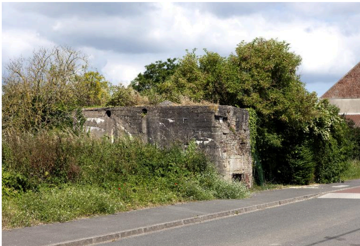
Vue de trois-quarts depuis la rue de sequedin, vers le nord-ouest
