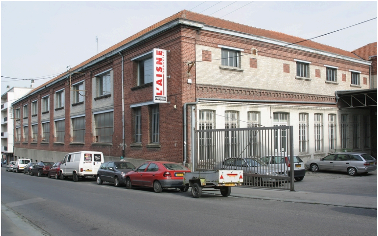
Ateliers et entrée principale de l'usine, rue Jean-de-Caulaincourt.
