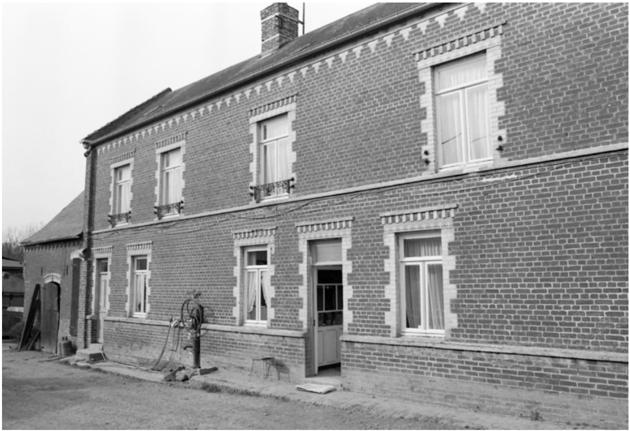
Logis : façade antérieure sur cour.
